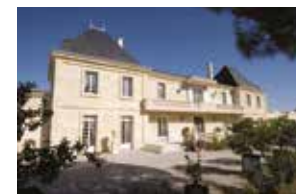
Château Arcins et Barreyres © Castel
