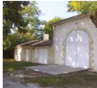
Château d'Osmond © Château d'Osmond
